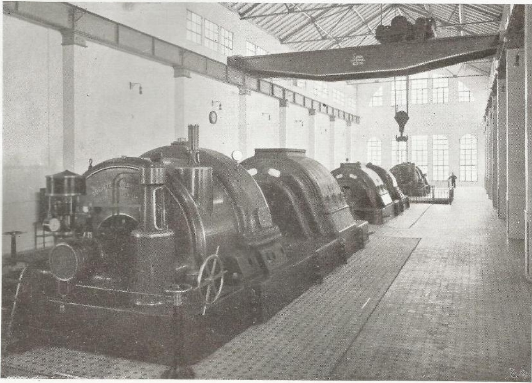
Sala de Máquinas (Central Térmica)
