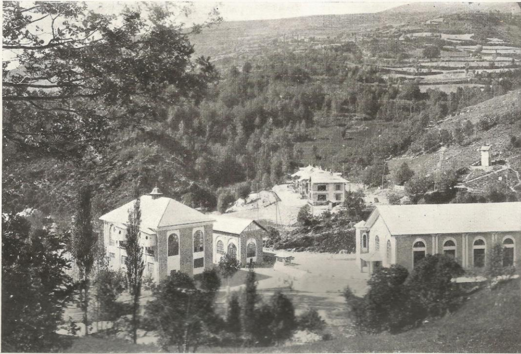
Vista parcial de las instalaciones de Molinos.
