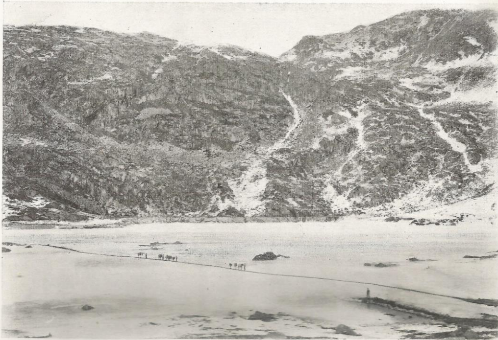
Transportes sobre el lago Mar, helado. (Central hidroeléctrica de Capdella).
