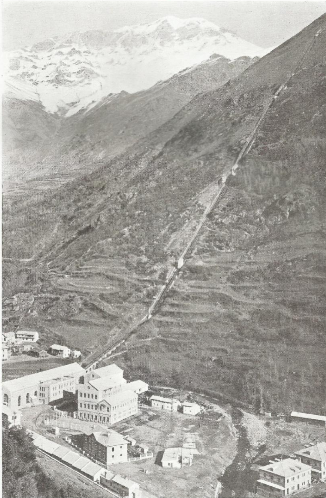
Central hidroeléctrica de Capdella (40,000 H.P.). Vista general de la Fábrica y tuberías
