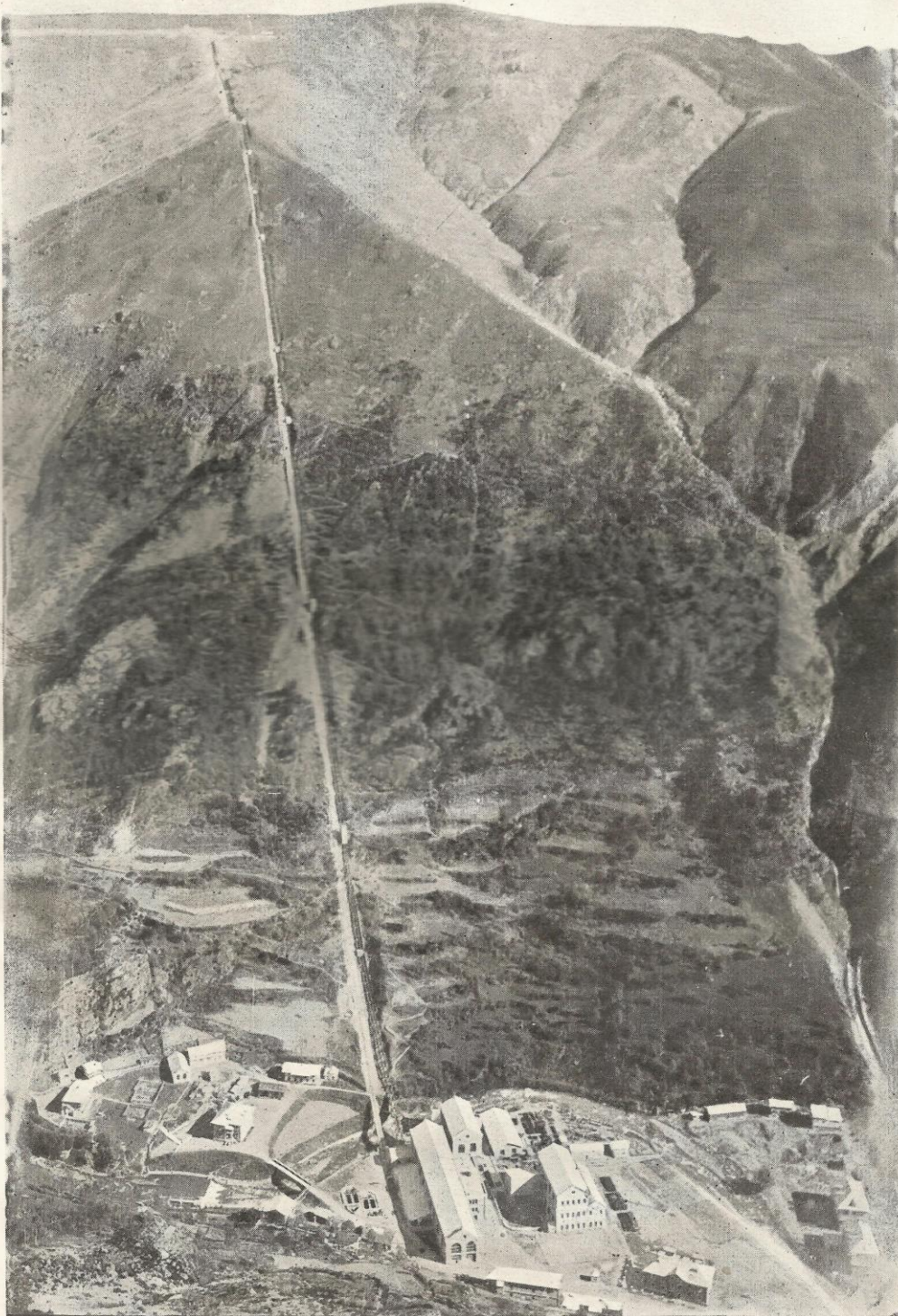
Central hidroeléctrica de Capdella (40,000 HP.). Vista de conjunto.
