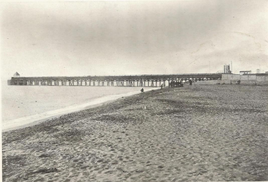
Central Térmica de San Adrián del Besós : Toma de agua del mar para refrigeración de los condensadores.
