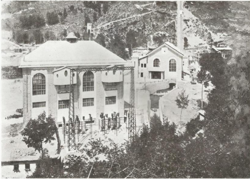
Estación transformadora y Central de Molinos
