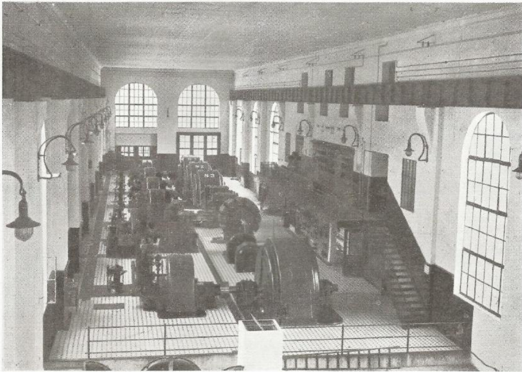
Sala de Máquinas (Central de Capdella)
