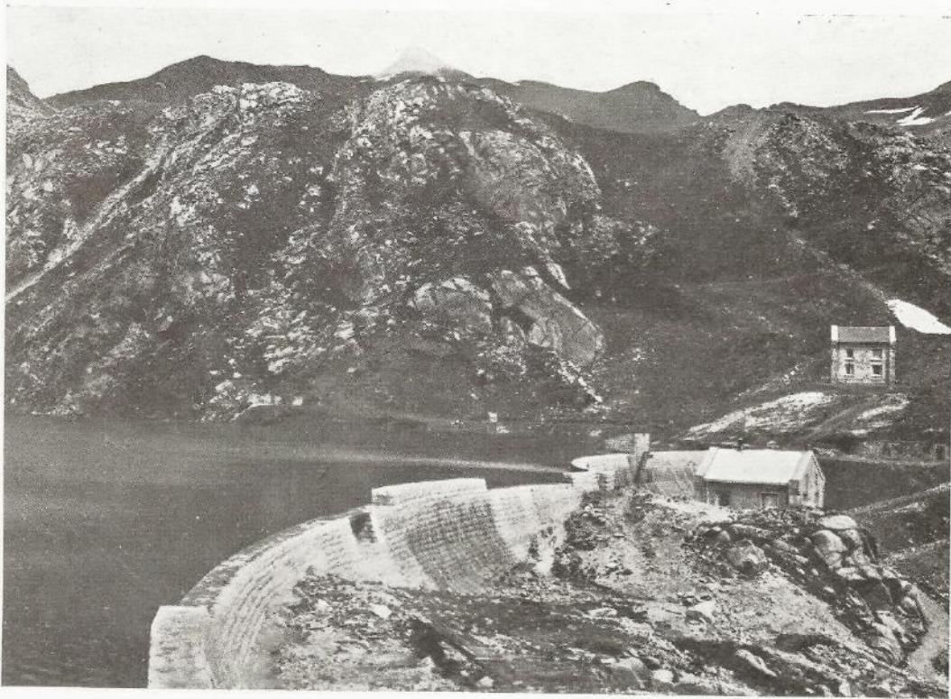
Presa del lago Estangento (Central hidroeléctrica de Capdella)
