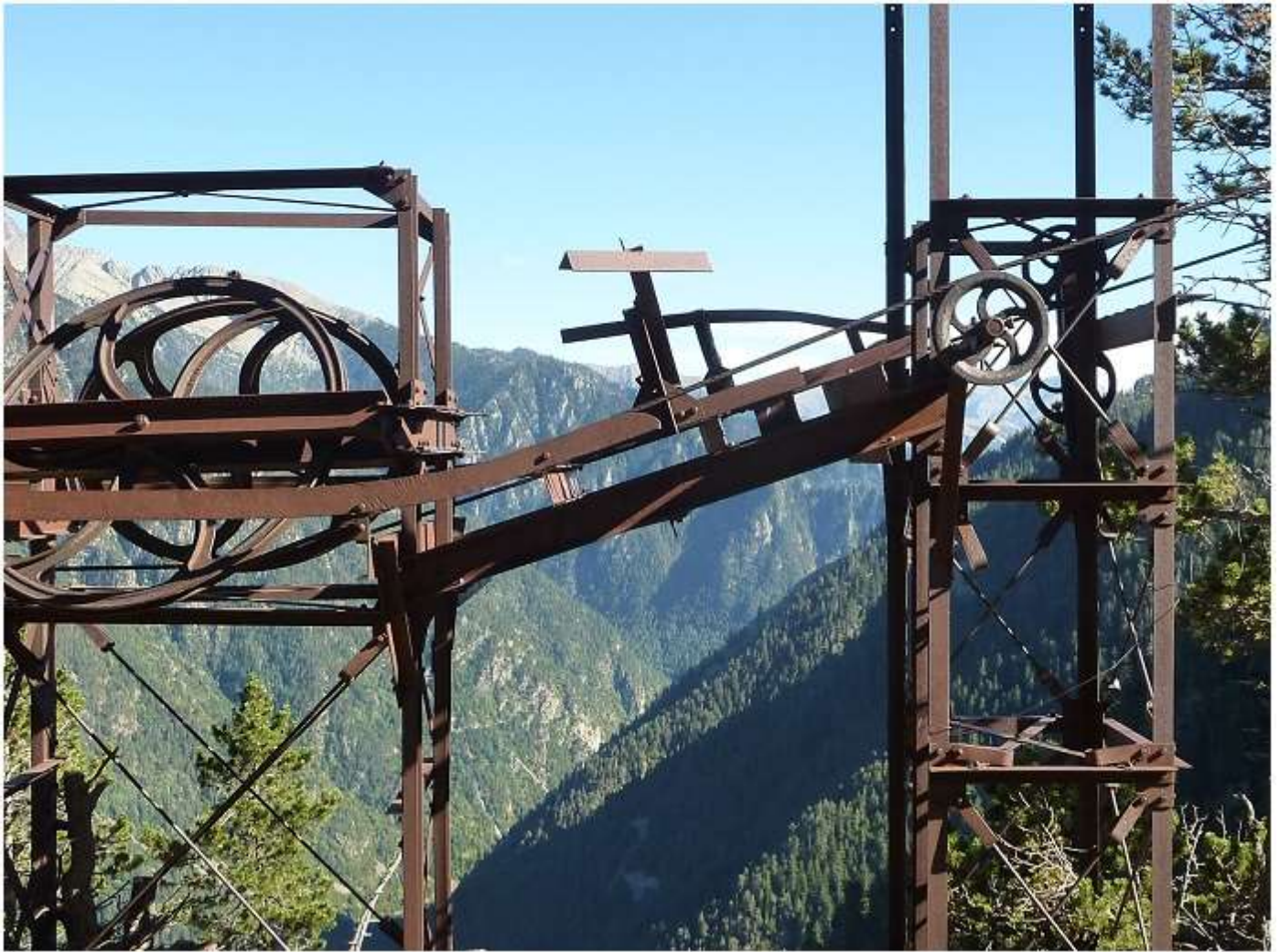
Figure 2 : Photo de la partie amont de la station d'angle de Liena , où les bennes doivent contourner sur un rail les poulies assurant l'angulation (voir la page de photos qui lui est consacrée) . Entre les deux structures on voit deux pièces métalliques dont l'une, au second plan, est le monorail L , et l'autre celle qui, au moment de la solidarisation de la benne et du câble, déclenche l'abaissement du levier chargé de renforcer la fermeture de la pince sur le câble ( fig. 4, 5 et vidéos ) (photo de Patrice Soutoul).
