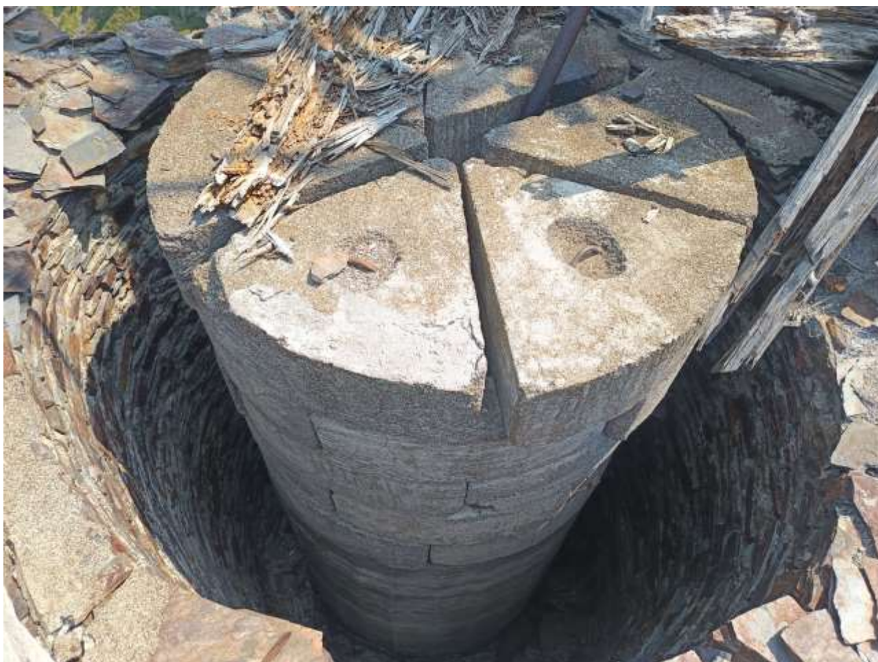
Els pesos “moliners” per tensar
