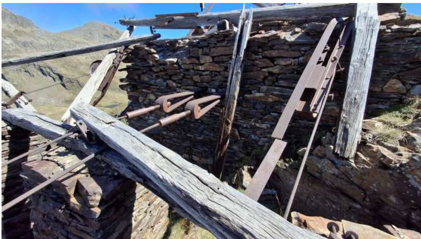
Ancoratges dels nous cables carril. Cal mesurar-los !
