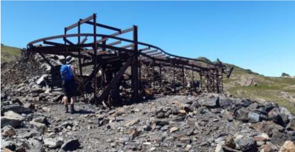
Encara es veuen bé els engranatges de la roda motriu i el sistema de frens.
