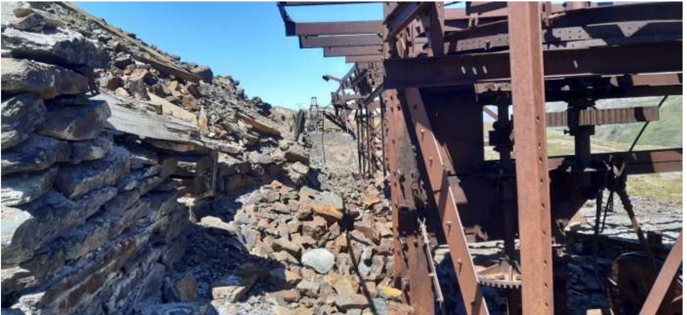
Banda sud, on encara queden restes de les boques de carrega dels dipòsits de mineral a les vagonetes.
