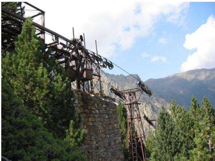
Vue sur la station d'angle et sur les deux pylones qui portent les câbles juste en dessous. Au fond, le pic Bataillance à droite, la sierra Pelada à gauche
