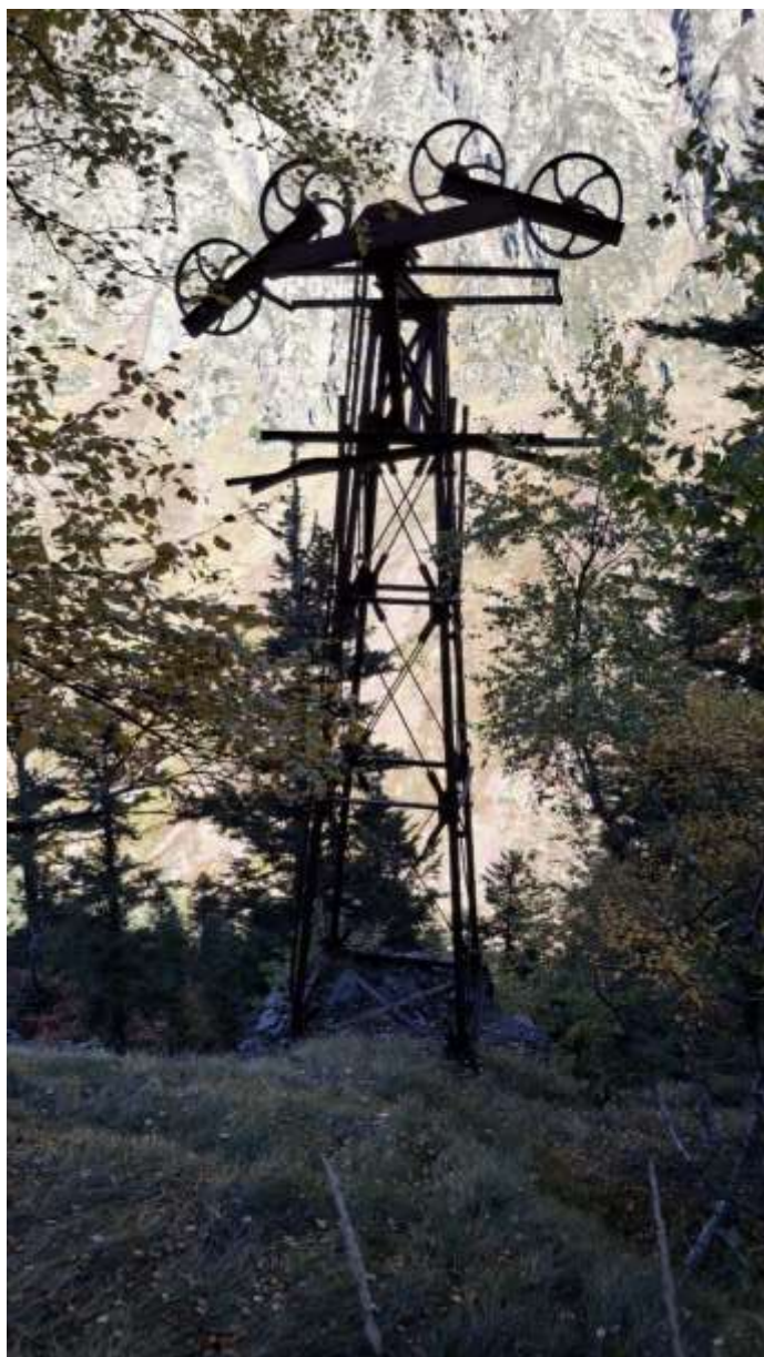
P23 Quasi al final del caminet enmig del bosc hi ha aquesta pilona quasi sencera, que només li manca les politges de la banda nord.
